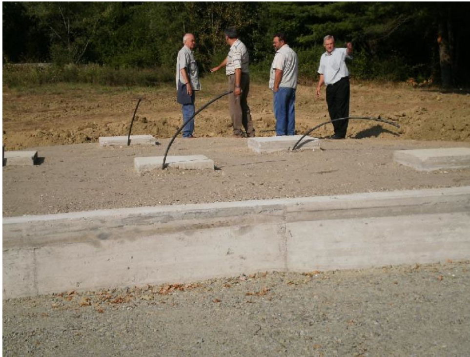
Porojektant arh. Silađin daje instrukcije izvođačima oko uređenja okoliša
